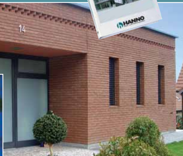
Objekt mit Fenster- und Fassadenfugen im Sichtmauerwerk
